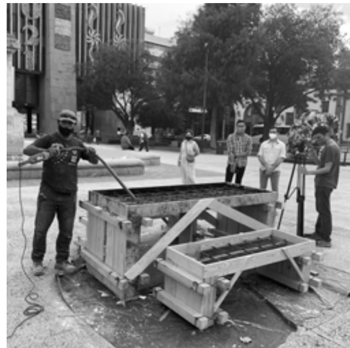
Vaciado de Una mesa y dos bancos , septiembre de 2021. Monterrey, México.
